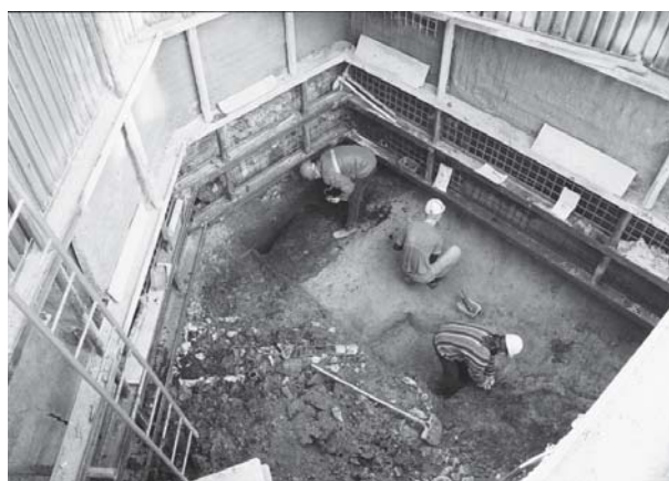
Obr. 43. Kobližná, Kozí, Poštovská, Sukova (A002/2003). Plošný odkryv ve spodní části těžní šachty TŠ 6. Pohled z jihovýchodu. Kobližná, Kozí, Poštovská, Sukova (A002/2003). Flächenabdeckung im Unterteil des Abbauschachts TŠ 6. Blick vom Südwesten.
