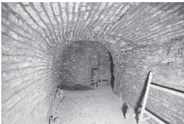
Obr. 37. Kapucínské náměstí (A115/2003). Část sanovaných sklepů, pohled ze severu. Kapucínské Platz (A115/2003). Teil der sanierten Keller, Blick vom Norden.
