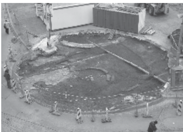
Obr. 61. Nám. Svobody (A093/2005). Počátek výzkumu v prostoru nově budované kašny, pohled ze severozápadu. Platz Svobody (A093/2005). Grabungsanfang im Raum eines neugebauten Trinkbrunnens.
