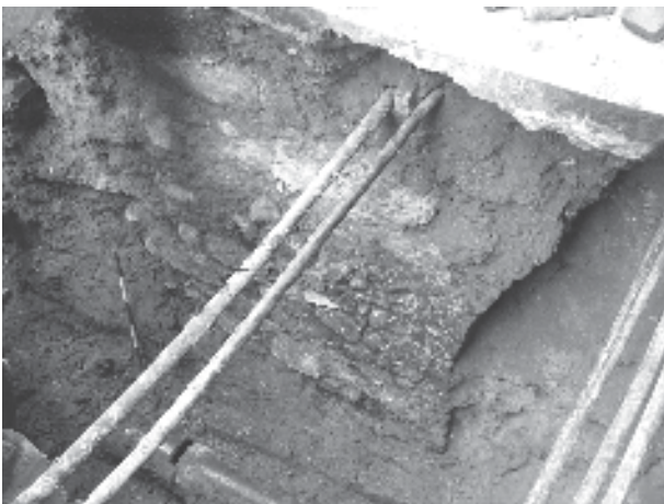
Obr. 30. Jakubská (A095/2005). Pohled od západu na východní stěnu odkrytého gotického sklepa. Jakubská Str. (A095/2005). Blick vom Westen auf die Ostwand des abgedeckten gotischen Kellers.
