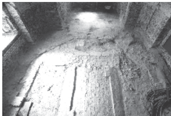
Obr. 53. Moravské nám. – kostel sv. Tomáše (A063/2005). Zčištěná úroveň historických konstrukcí. Moravské Platz – St. Thomas Kirche (A063/2005). Geputzte historische Mauern.
