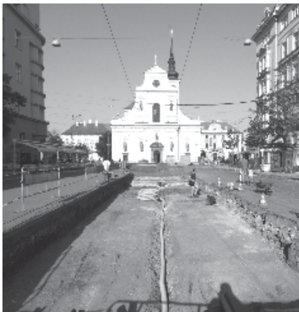
Obr. 35. Joštova, Moravské nám., Rašínova (A028/2005). Pohled od západu na plochu na Joštově ulici. Joštova Str., Moravské Platz, Rašínova Str. (A028/2005). Blick vom Westen auf die Fläche in der Joštova StraÙe.
