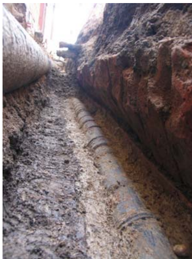
Brno, Kobližná - Poštovská. Odkrytý novověký vodovod.
