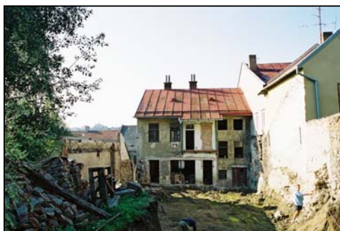
Obr. 1 – pohled na stavební jámu.
