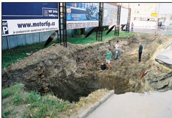
Obr. 1 – pohled na stavební jámu.
