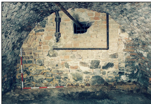
Obr. 12: Brno, Kobližná 4, východní stěna místnosti 1.07 se zazděným původním vstupem a odkládací nikou z 1. pol. 14. stol. (nejstarší zděná zástavba – dům I). Zazdívka pochází ze druhé gotické fáze. Foto archiv Archaia Brno i.č. A98-59-168.
