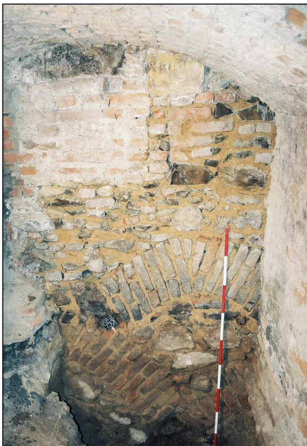
Obr. 11: Brno, Kobližná 4, severní stěna místnosti 1.03 se zazděnou špaletou osvětlovacího okénka a vynášečními pasy z 1. pol. 14. stol. (nejstarší zděná zástavba – dům I). Foto archiv Archaia Brno i.č. A98-59-170.
