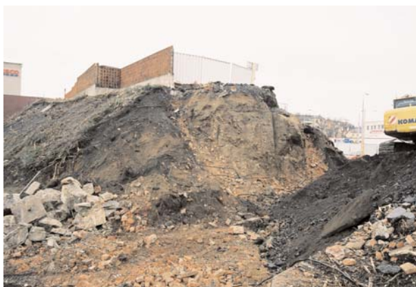
Obr. 59. Úzká (A051/2004). Řez starým železničním nás- pem. Úzká (A051/2004). Schnitt durch die alte Eisen- bahnböschung.
