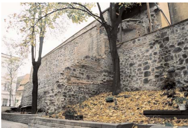
Obr. 47. Husova 10 (A003/2004). Opravený úsek hradby. Husova 10 (A003/2004). Repariertter Abschnitt der Stadtmauer.
