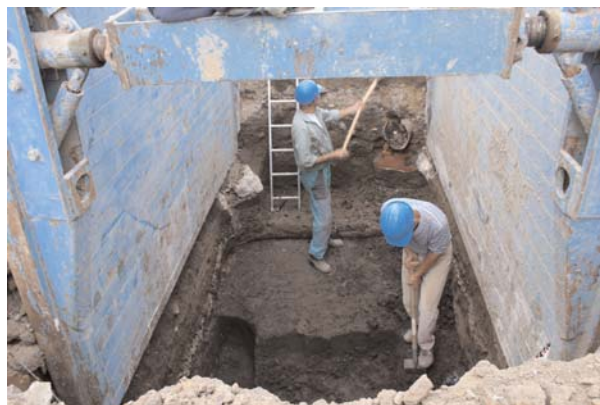
Obr. 65. Koliště (A064/2004). Archeologické práce v jedné ze sond. Koliště (A064/2004). Archäologische Arbeit in einem der Suchschnitte.
