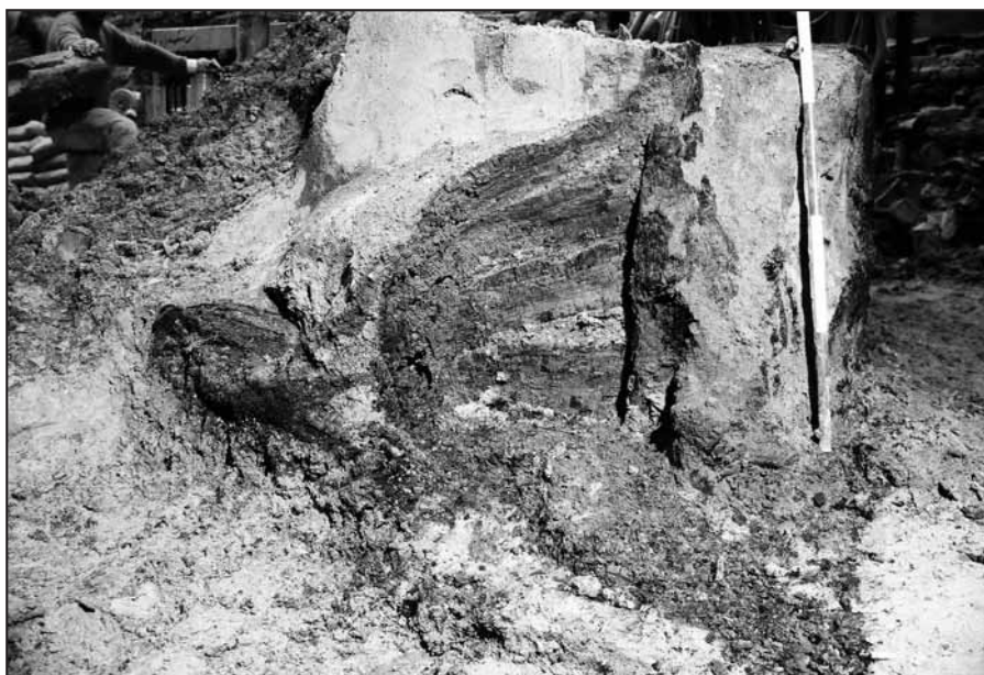
obr. 13 Pozůstatky dřevěné konstrukce severní stěny vstupní šije suterénu s. s. j. 2 z náměstí Svobody 17.
