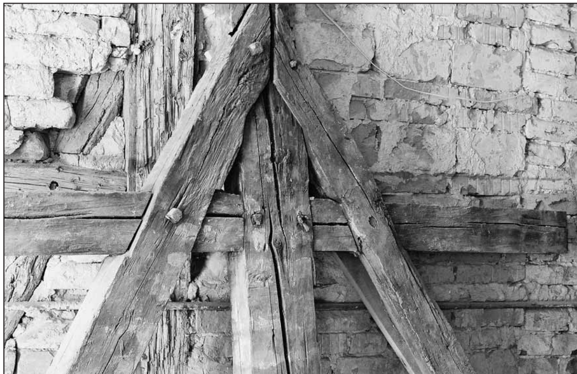
Abb. 23 Detail der Fachwerkkonstruktion des Hauses Mečová 8 (dendrochronologisch datiert nach dem Jahre 1450).
